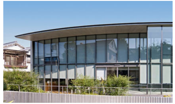
Obwohl Innenjalousien und helle Vorhänge hinter den Scheiben Reflexionen reduzieren können, kommt es häufig zu Spiegelungen. Mit einem wirksamen Schutz vor Kollisionen ist nicht zu rechnen, zumal Jalousien nicht dauerhaft heruntergelassen sind.
