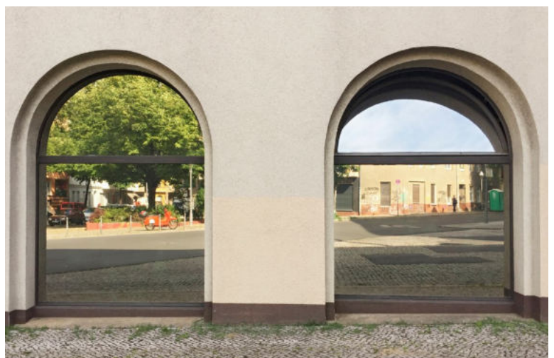
Spiegelnde Sonnenschutzfolien erzeugen realistische Spiegelbilder: Vögel nehmen diese Fenster als Durchflugsopption wahr.
