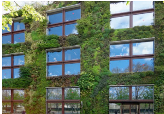
Fassadenbegrünung am Musée du Quai Branly in Paris. Solche Massnahmen zur Förderung der Artenvielfalt und zur Verbesserung des Stadtklimas müssen Hand in Hand mit Massnahmen gegen Vogelanprall gehen.
