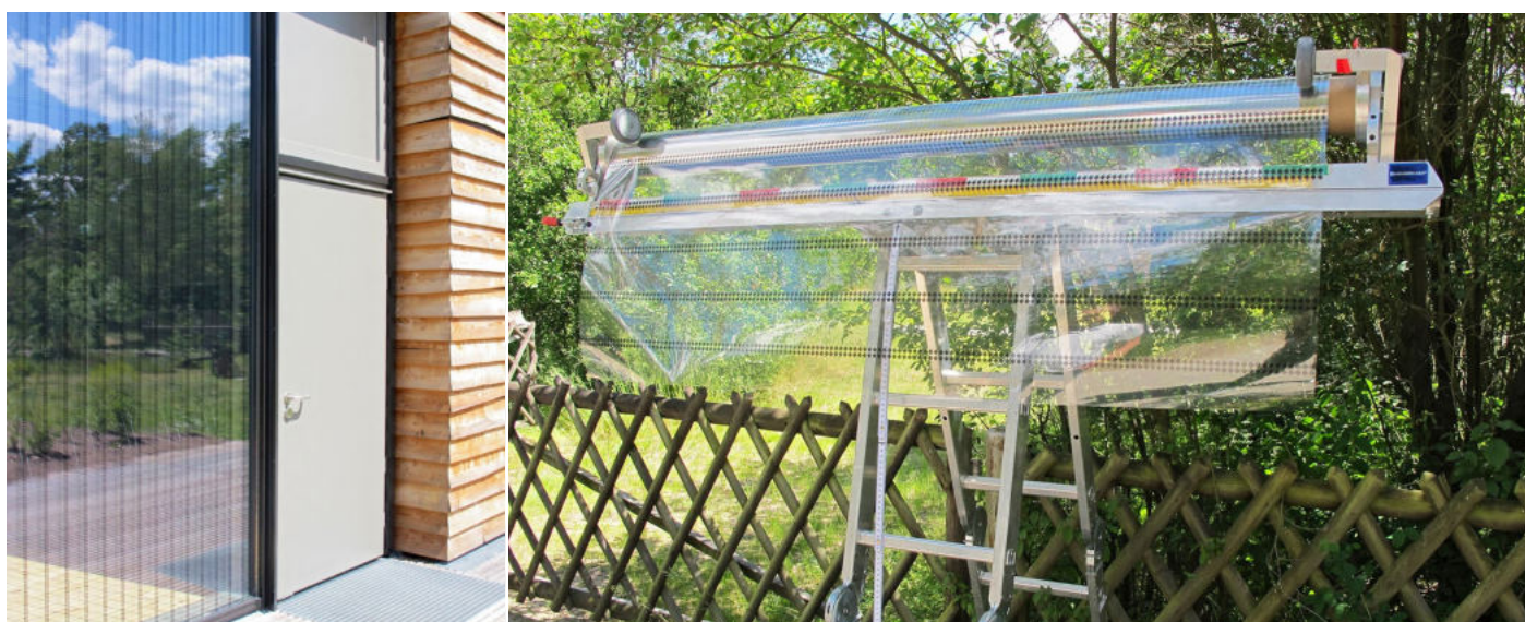
Bedruckte Folien werden vollflächig aufs Glas aufgebracht.
