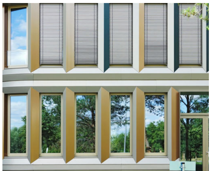
Im heruntergelassenen Zustand können Aussenjalousien vor Kollisionen schützen. Als dauerhafte Lösung eignen sie sich jedoch nicht, da diese Massnahme nutzerabhängig ist.
