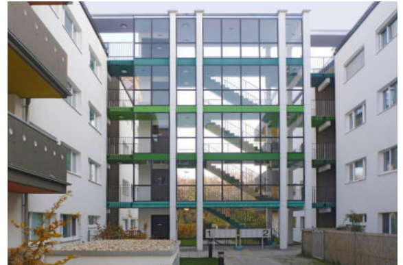
Die von Glaswänden und verglasten Gängen ausgehende Gefahr wird verschärft, wenn Gebäude auf beiden Seiten die Vögel unausweichlich zum verglasten Hindernis lenken.
