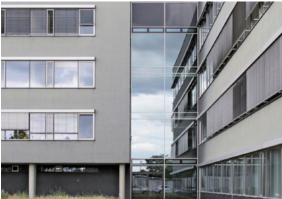
Lange Fensterbänder und spiegelnde Glasflächen werden von Vögeln als grosszügige Durchflugsmöglichkeit durch die Gebäudestruktur wahrgenommen. Die einzelnen Unterteilungen der Glasflächen haben dabei keinen kollisionsmindernden Einfluss.
