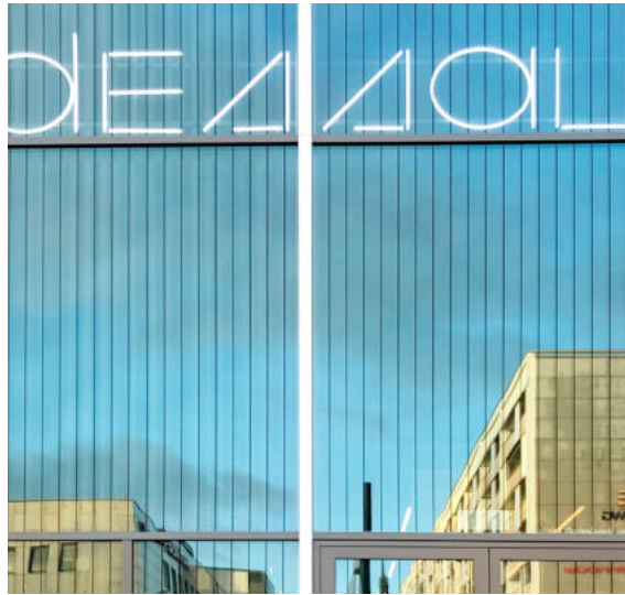
Zur Sicherung gegen Vogelanprall am neuen Bauhaus Museum in Dessau wurden mehr als 2700 m 2 Fassadenglas nachträglich mit einem ausgeplotteten Linienmuster versehen.
