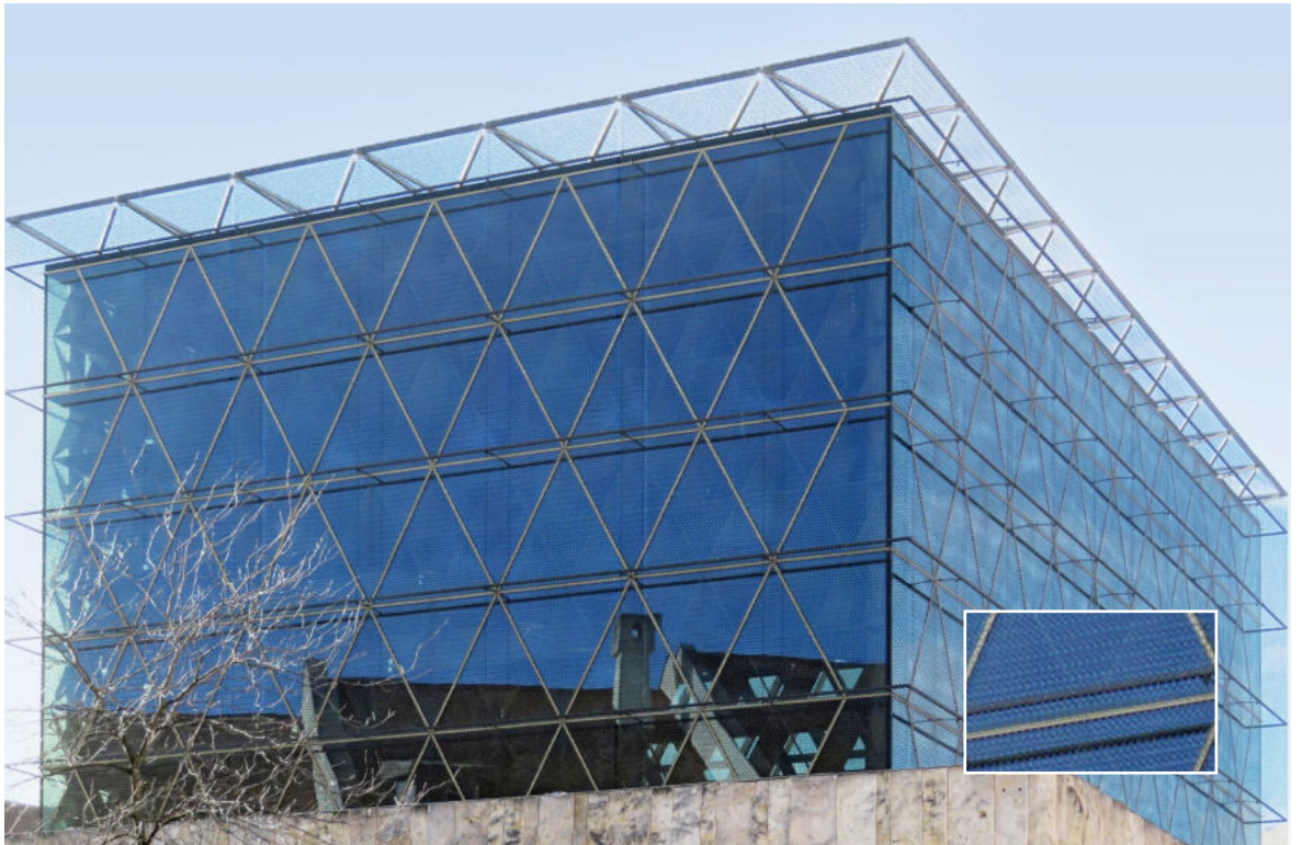
Der Glaskubus des Jüdischen Zentrums von Wandel Hofer Lorch + Hirsch in München ist umgeben von einer stählernen Stützkonstruktion und einem Bronzegewebe. Ein Dreiecksmuster aus Davidsternen sorgt durch das Spiel von Licht und Schatten im Gebetsraum für eine besondere Atmosphäre.
