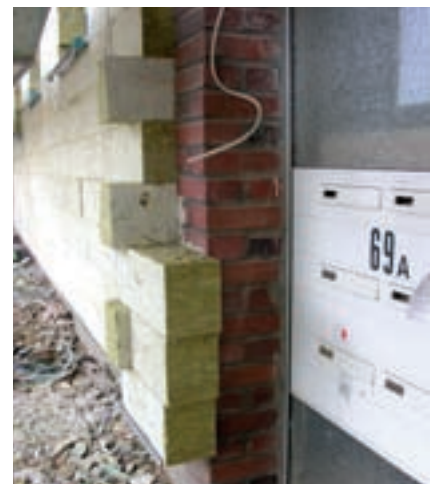
Auftragung einer Dämmung
