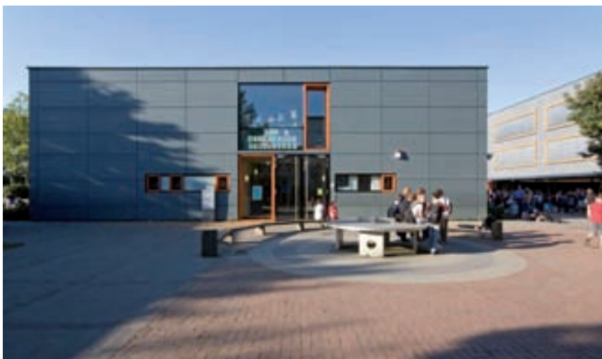
Düsseldorf, Umbau/Sanierung Städt. Georg-Schulhoff-Realschule
