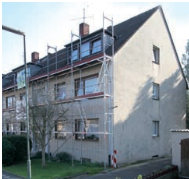
Sanierung eines Mehrfamilienhauses in Düsseldorf
