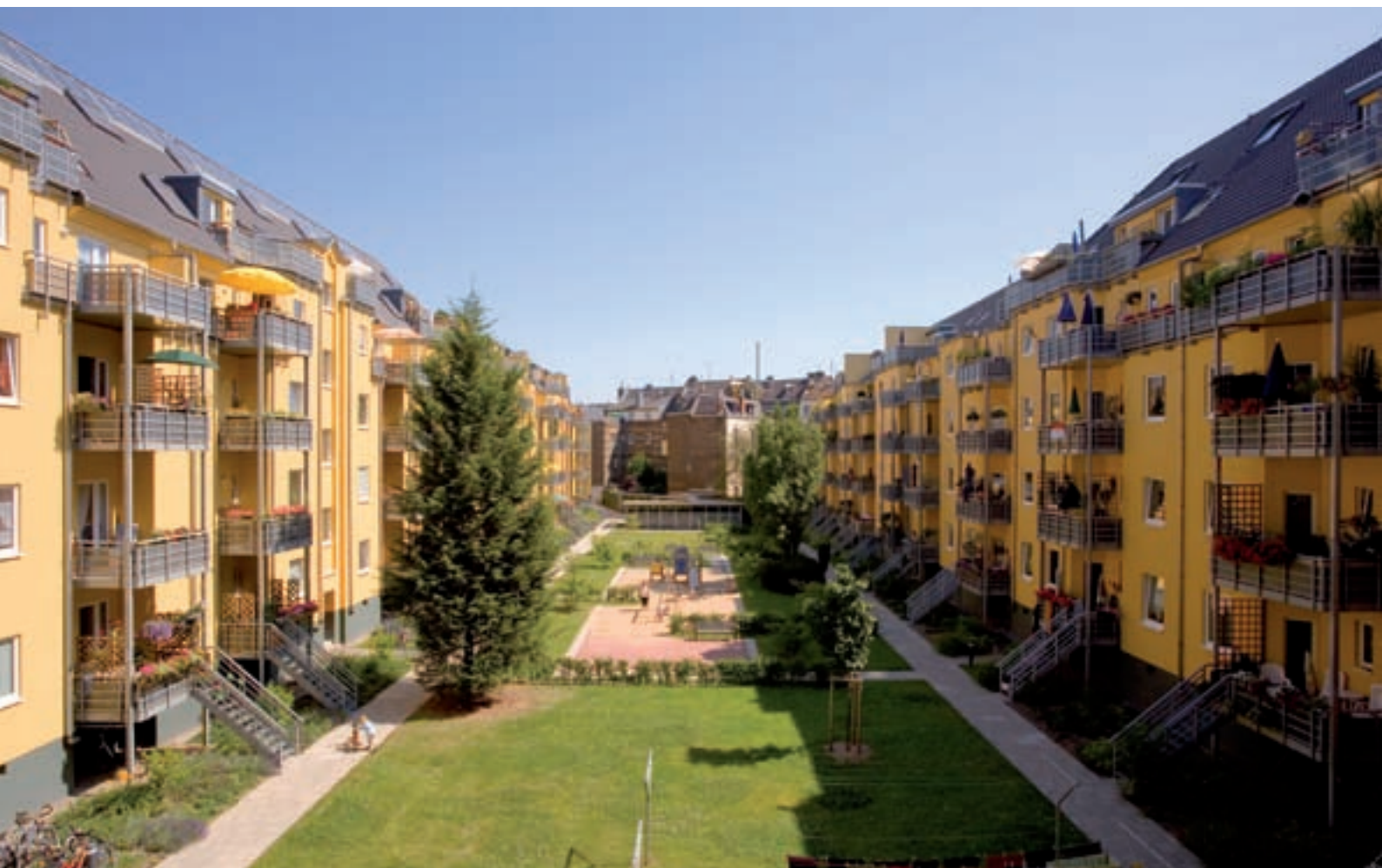
Umbau einer Bestandssiedlung in eine Solarsiedlung in Köln-Riehl
