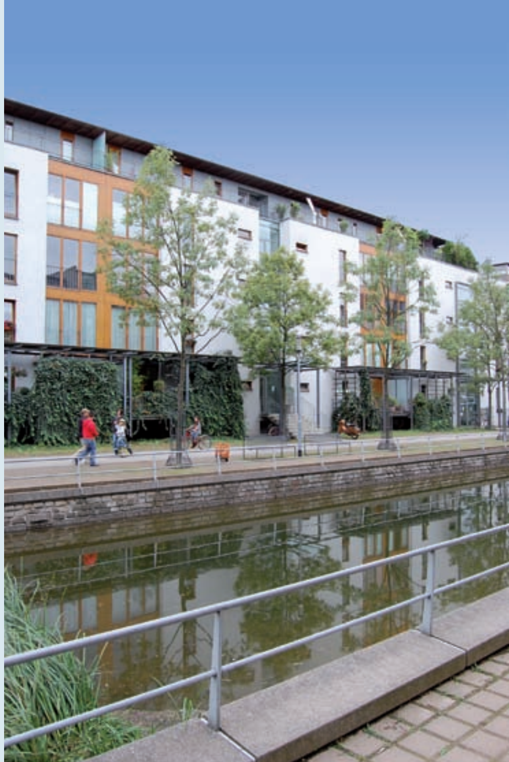
Bestandsentwicklung am Beispiel Duisburg Innenhafen
