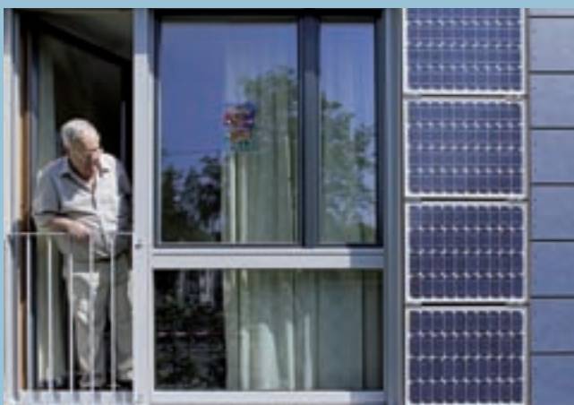
Kollektoren als Fassadenelemente
