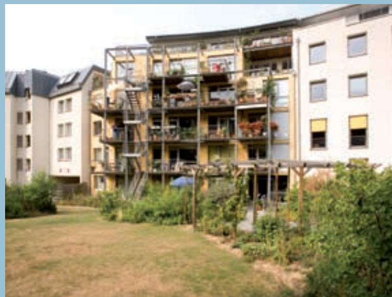
Bauen im Bestand in Aachen (Friedlandstraße)
