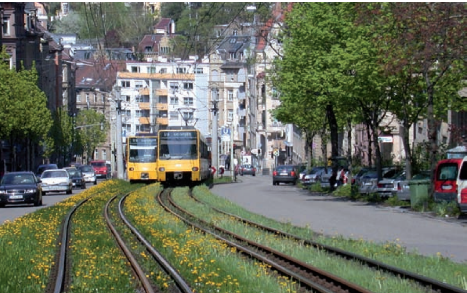
Trassenbegrünung in Stuttgart
