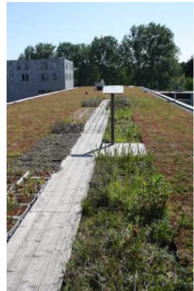
Abbildung 73: Dachbegrünungen bieten sich auf Flachdächern an (Foto: ZSK TP1)
