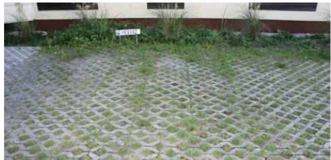
Abbildung 45: Parkplätze können teilentsiegelt werden und Versickerung ermöglichen (Foto: ZSK TP1)
