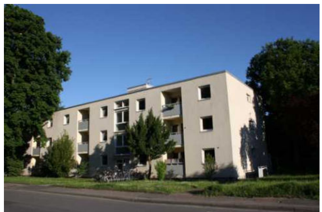
Abbildung 76: Zwischen den Baukörpern bieten Zeilenbebauungen Platz für Begrünungen (Foto: ZSK TP1)
