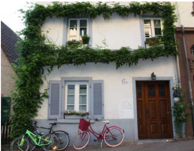
Abbildung 100: Fassadenbegrünung am Wohngebäude (Foto: ZSK TP1)
