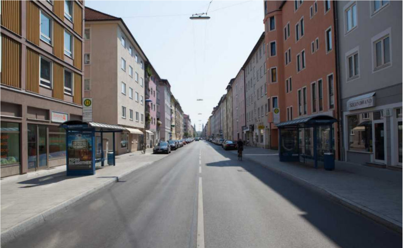
Abbildung 10: Hochversiegelte Flächen heizen die Stadt auf (Foto: ZSK TP 1)
