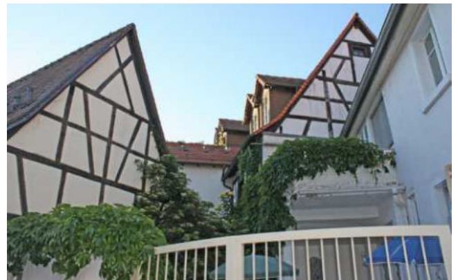
Abbildung 103: Beispiel begrünter Bauteile am Fachwerk (Foto: ZSK TP1)
