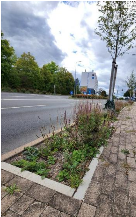
Abbildung 48: Erfurt: Neupflanzung in einem langen schmalen Wurzelgraben. Foto: Annette Hartmann, 2025
