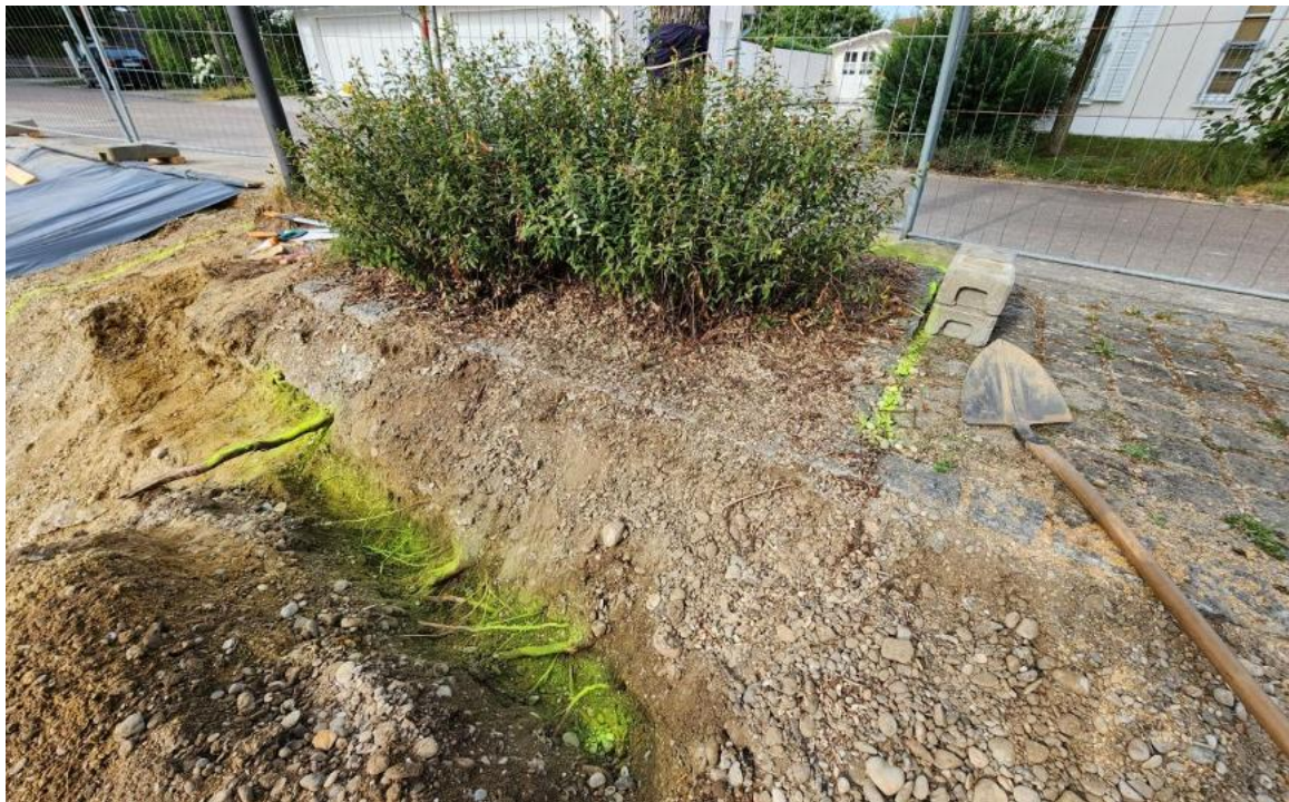
Abbildung 37 Wurzelsondierung per Handschachtung: Schaufeleinsatz. Foto: Annette Hartmann, 2025.
