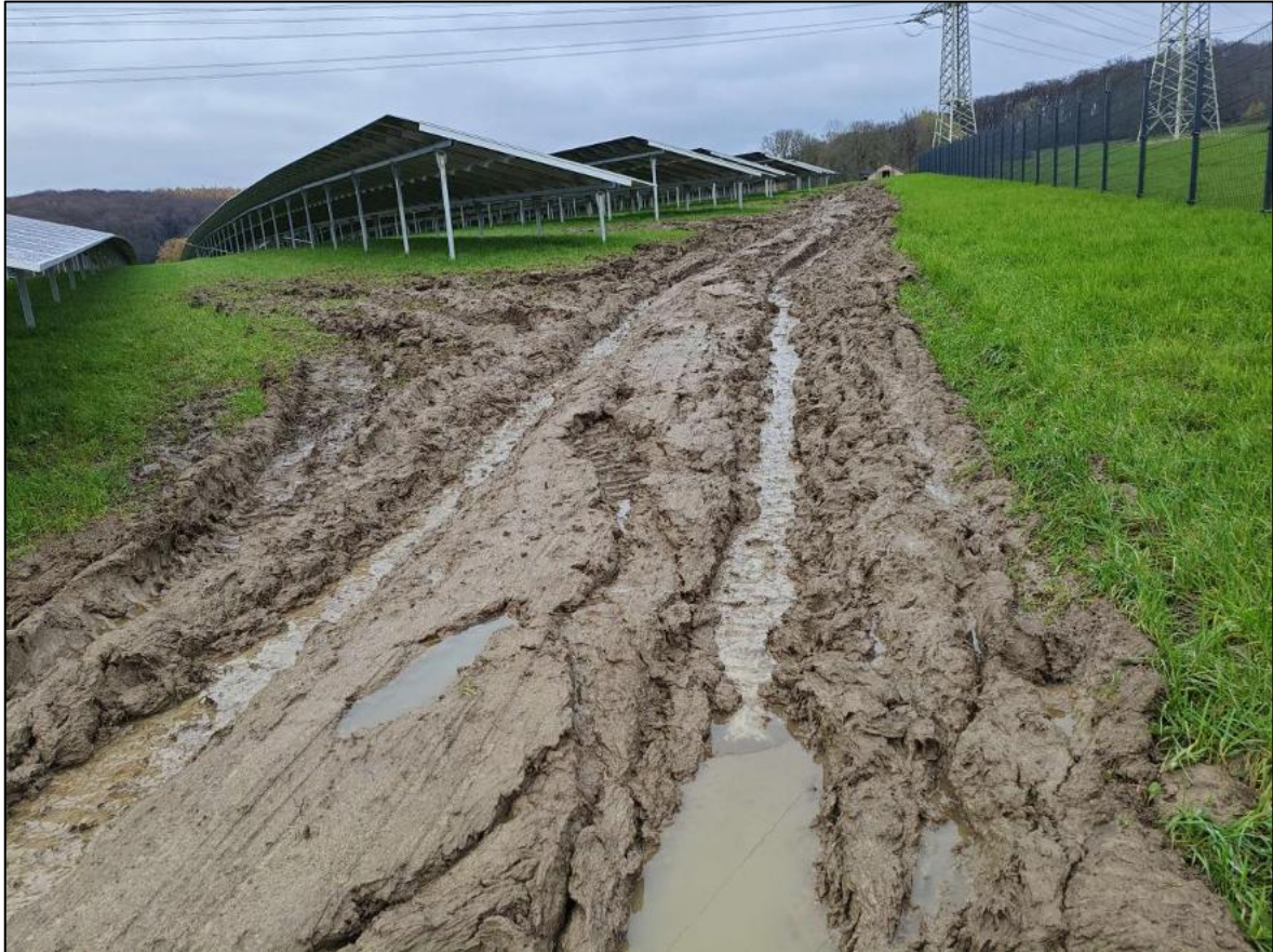
Abbildung 7 Erhebliche Verdichtungsschäden auf dem Umlaufweg einer PV-FFA im Bergischen Land, die durch Befahrungen ungeschützter Böden im Winterhalbjahr entstanden sind (Quelle: Ingenieurbüro Feldwisch).
