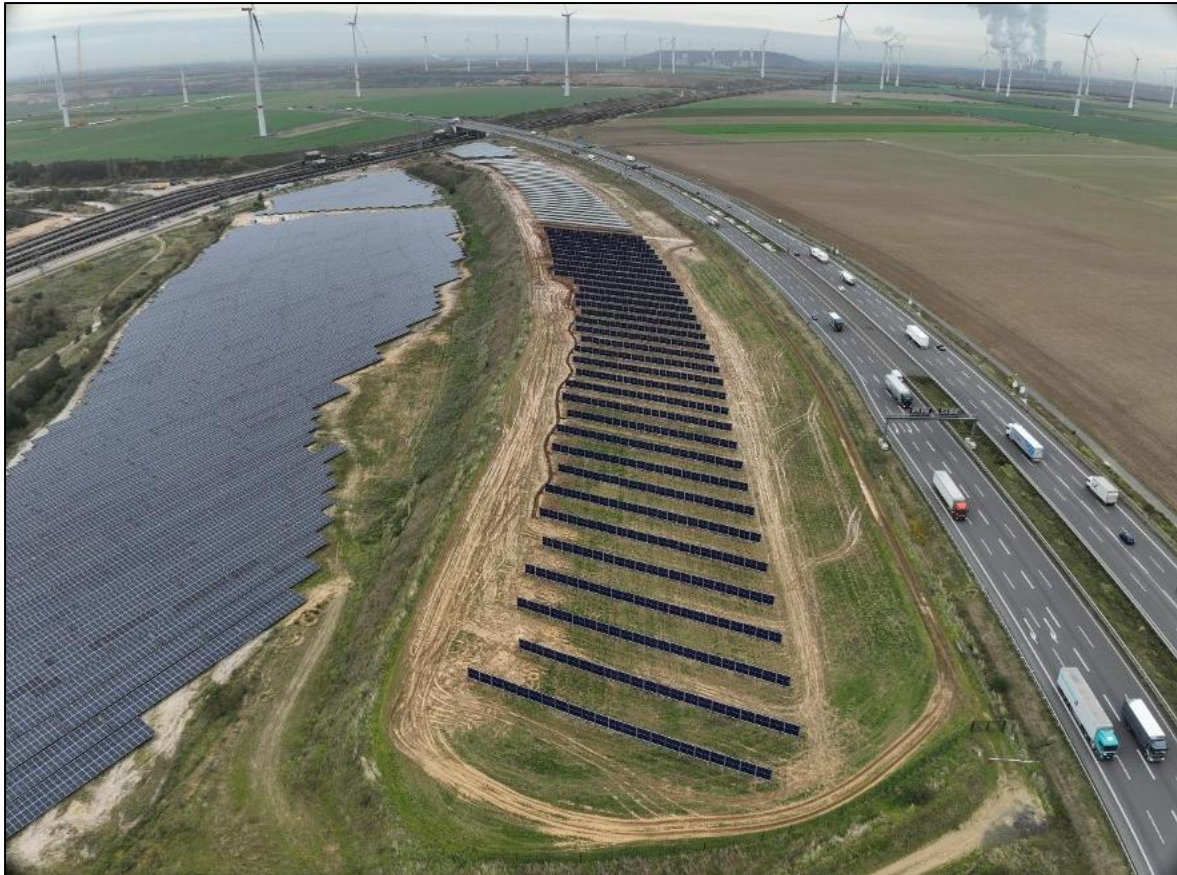
Abbildung 3 Starke Verdichtungsschäden im Zuge des Baus einer vertikalen Agri-PV-Anlage (Quelle: Ingenieurbüro Feldwisch).
