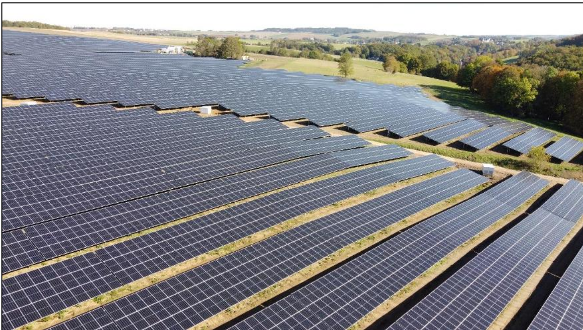
Abbildung 1 Bau einer über 23 ha großen Photovoltaik-Anlage bei Zwickau (Quelle: Ingenieurbüro Feldwisch).
