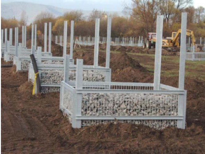
Abbildung 50: Beispiel für ein Gabionenfundament (Steine in Stahlkorb)
