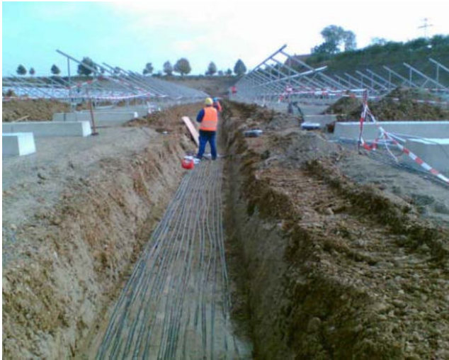
Abbildung 6: Beispiel für die Verlegung der Erdkabel im Kabelgraben
