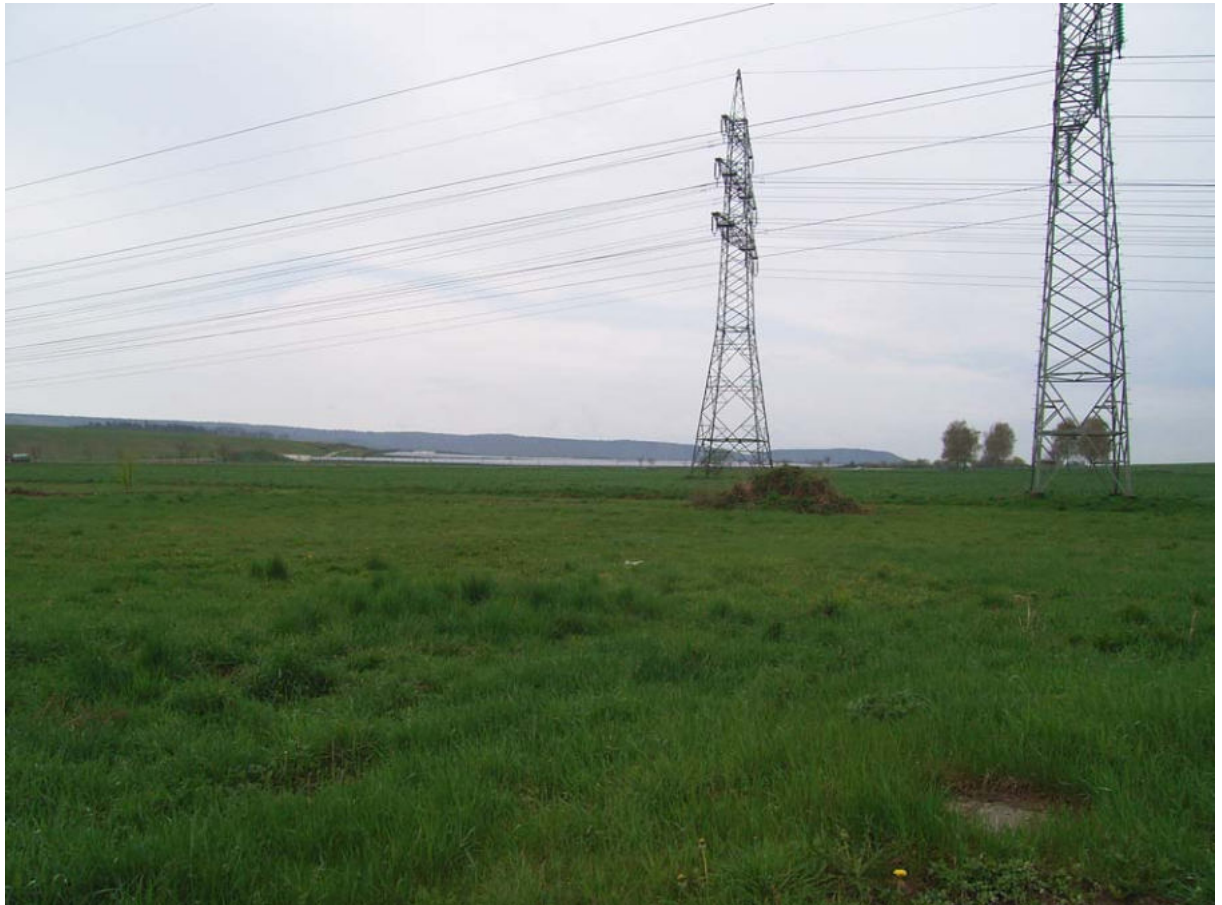
Abbildung 45: Solarpark Mühlhausen, Beobachtungspunkt 2, 500 m östlich der Anlage:
