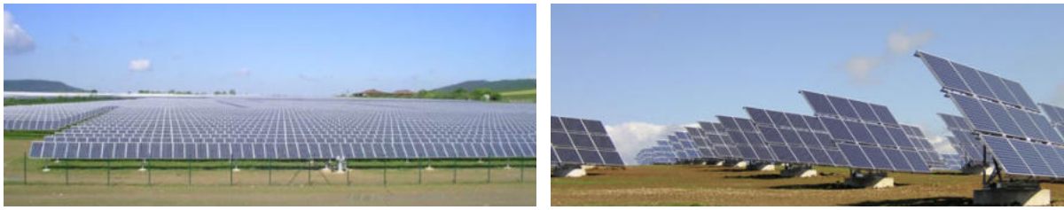
Abbildung 15: Beispiele für die Aufständering von PV-Modulen
