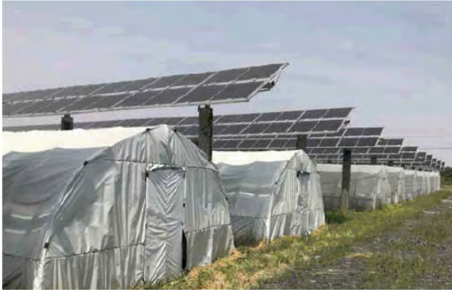
Bild 36: PV-Module über einem Folientunnel.
