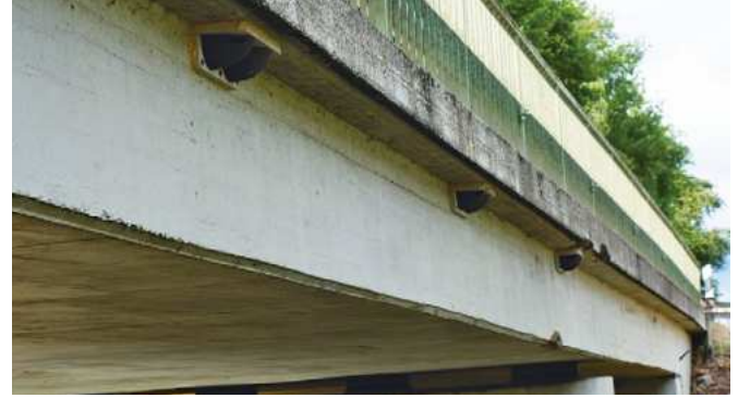
Mehlschwalben-Nisthilfen an einer Brücke.
