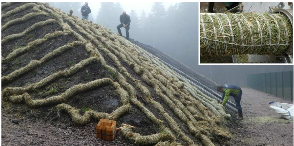
Abbildung 9: Heustränge bringen nicht nur zusätzlich autochthones Pflanzenmaterial auf angesäten Rohböden, sondern schützen durch ihre Befestigung den Oberboden vor Winderosion und Schlagwasser. Foto: L. Unseld, DVL
